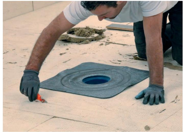
Im Technikfilm *Detail Dachablauf* werden die einzelnen Arbeitsschritte zur sicheren Ausführung als Animation und in einer Schulungsumgebung ausführlich gezeigt, zu sehen auf [www.derdichtebau.de](http://www.derdichtebau.de).
