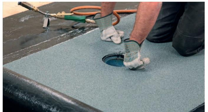
Nach Fertigstellung der ersten Abdichtungslage wird mit dem Aufbringen der mineralisch bestreuten Oberlagsbahnen im Lagenversatz begonnen.
