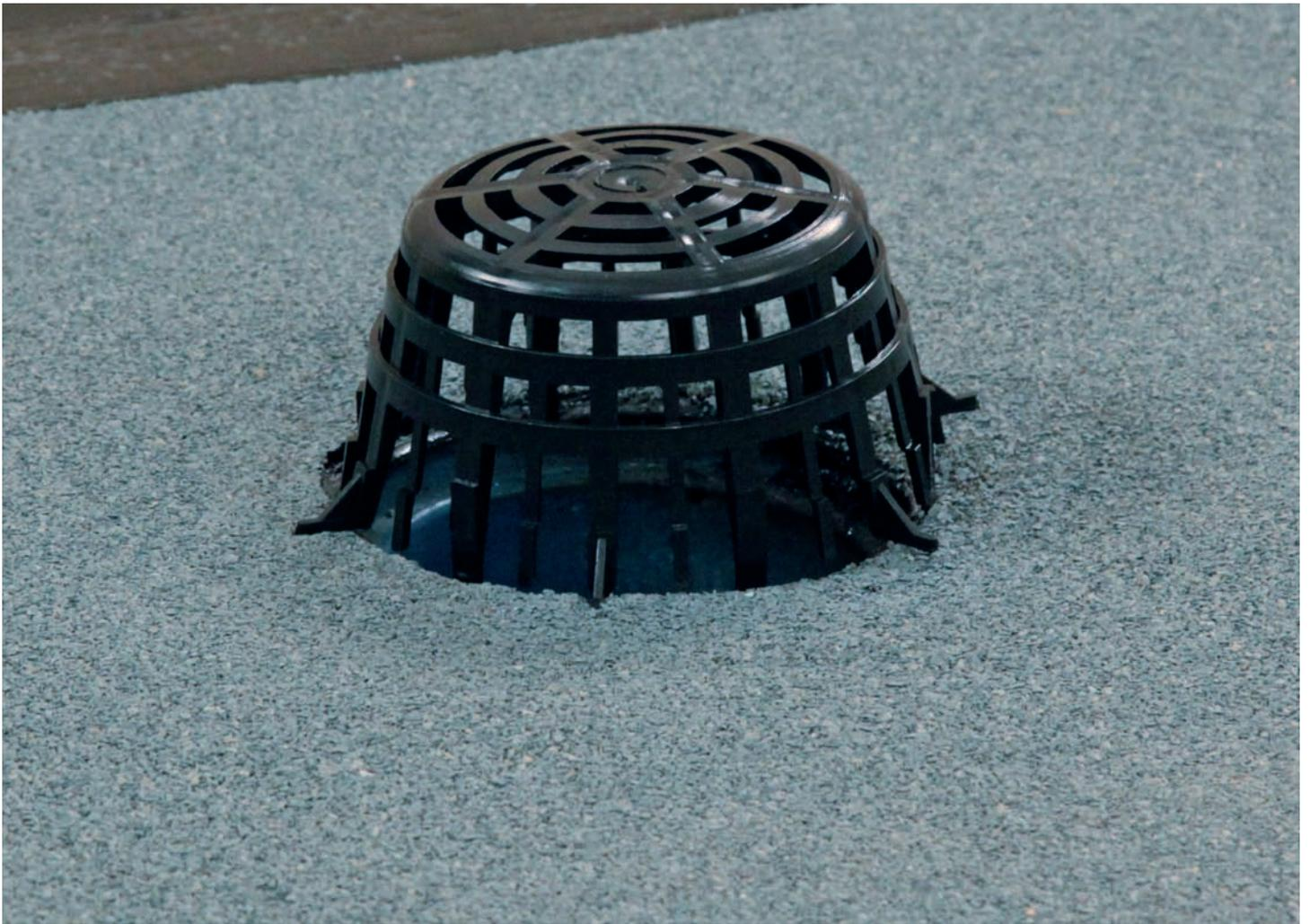
Abschließend wird der Kies- und Laubfang eingesetzt.
