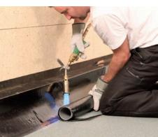
Nach Fertigstellung der unteren Abdichtungsebene kann mit dem Aufbringen der mineralisch bestreuten Oberlagsbahnen im Lagenversatz begonnen werden. Zunächst werden die einzelnen Bahnen dabei bis zum Keil vollflächig auf die erste Abdichtungslage aufgeschweißt.
